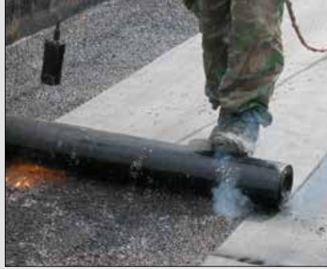
Unterbau für Schweissbahnen
