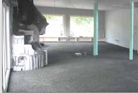
Ausgleichen von Installationsleitungen
