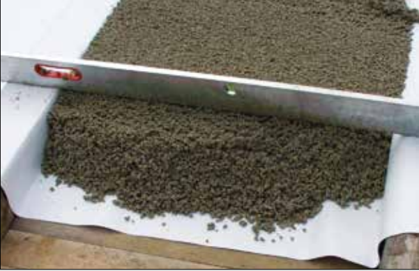
Höhenausgleich auf Holzbalkendecken
