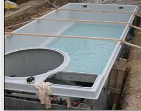
Hinterfüllung von Schwimmbecken
