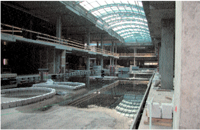
Mall-Bereich vor dem Einbau von Thermozell-Leichtbeton.
