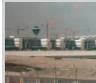
Flughafen München, Terminal 2 (Ausführung 2002, Menge 8000m 2 . Ausgleich von Kabelkanälen).
