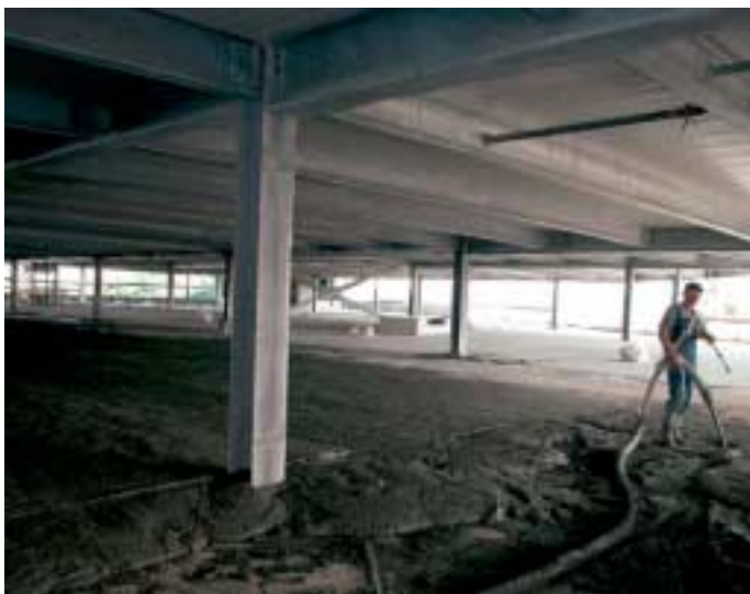
Einbau von Thermozell-Leichtbeton im Gefälle.
