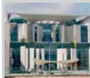
Bundeskanzleramt, Berlin (Ausführung 1999, Menge 417m 2 . Auffüllen von tieferliegenden Bereichen am Dach).
